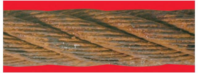
d. Halatın oksidasyon nedeni ile malzeme kaybı yaşamaya başlaması - Değerlendirme: %100 (Halatı acilen servis dışına alınmalıdır)
